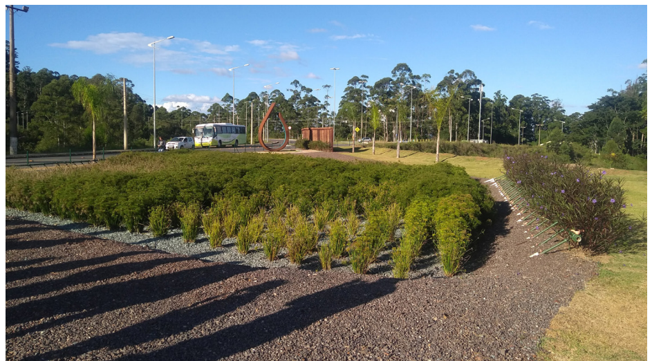
Wetland construído para tratamento de efluentes domésticos de edifício de escritórios da VALE na Mina de Águas Claras, em Nova Lima/MG, associado a praça de convivência dos funcionários. Fonte: acervo pessoal de Cristiane Borda Pinheiro, 2018.
