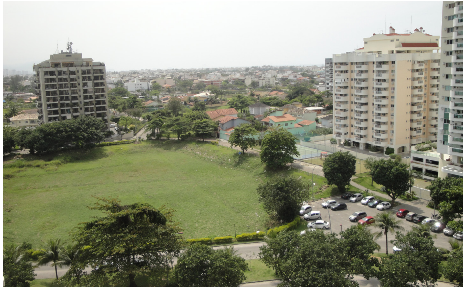
Bacia de retenção gramada no Rio de Janeiro/RJ. Fonte: acervo pessoal de Cristiane Borda Pinheiro, 2010.
