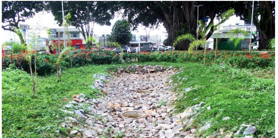
Trincheira de infiltração na Praça Dom Emanuel em Anápolis/ GO. Fonte: acervo pessoal de Antônio Zayek, 2020
