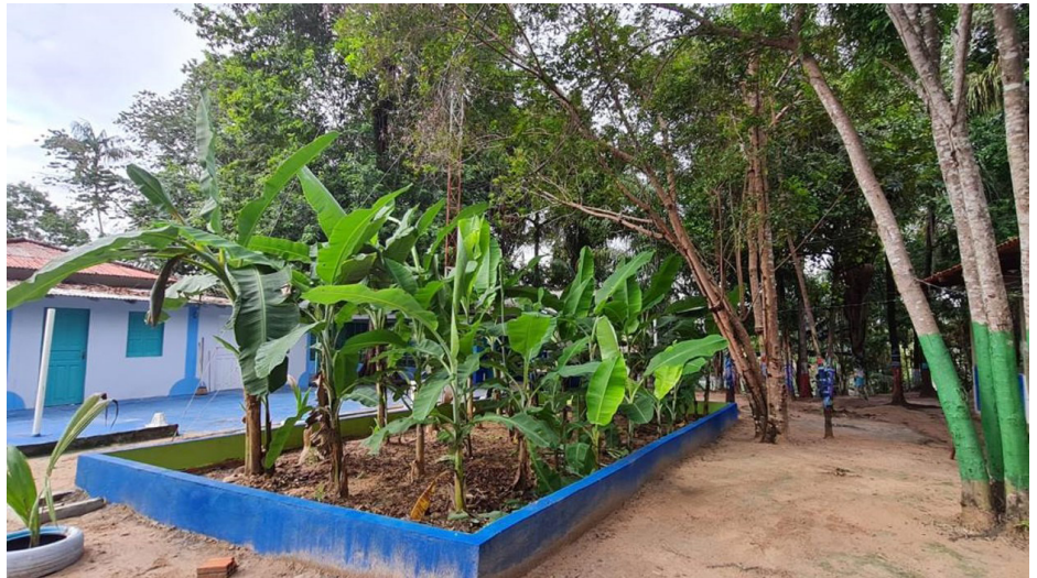
Bacia de evapotranspiração em Roraima, replicada a partir de piloto do Projeto ANDUS, na comunidade Recanto do Davi, de recuperação de dependentes químicos.
