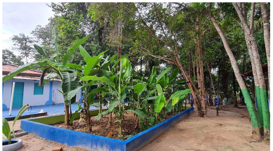
Exemplo de Bacia de Evapotranspiração (BET) executada no estado de Roraima.
